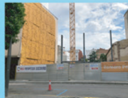
Principi de les obres
