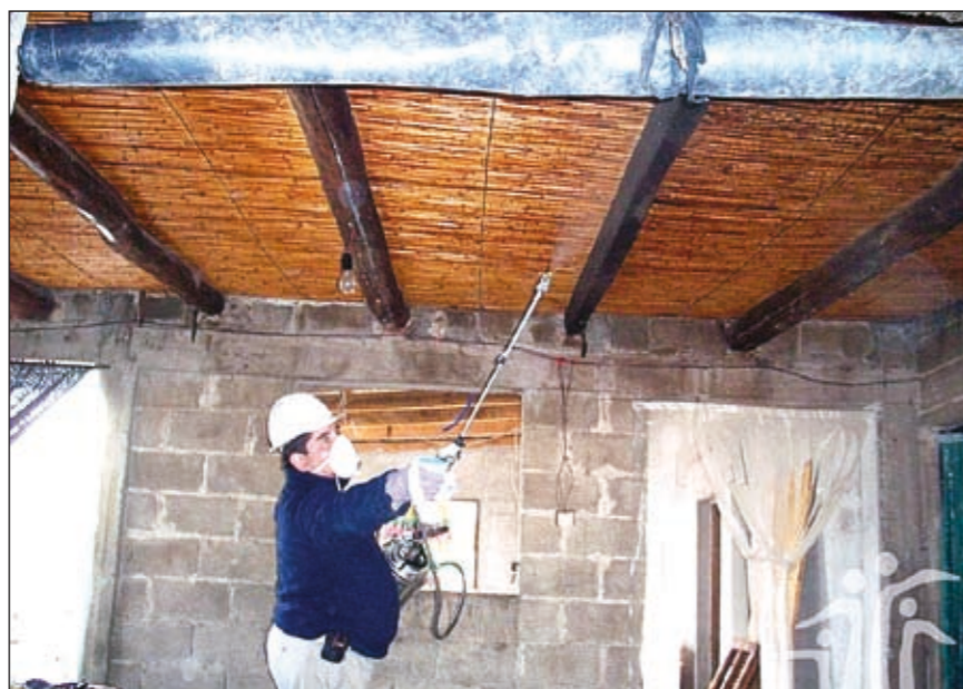
Fumigació de les instal·lacions
