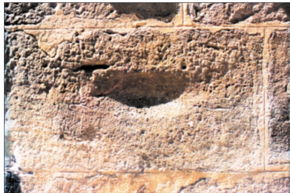
Empremta deixada pels caps del condemnats encadenats al Pilar de General
