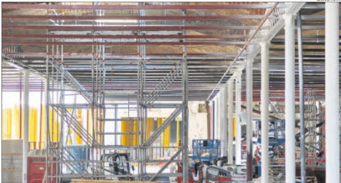
Estat actual de les obres a l'interior dels Docs, amb diversos pilars pintats de blanc.
